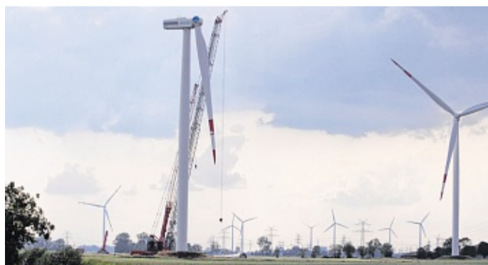
Mit Hilfe von Kränen wird die Reparatur an der Windkraftanlage vorgenommen. FOTO: SABINE KOLZ
